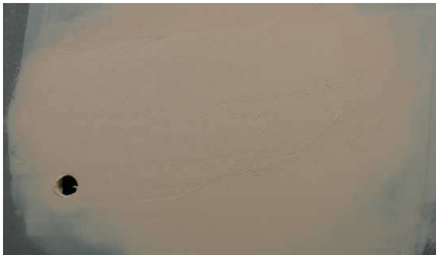
Рис. 2.5. Применение классической наполняющей шпатлевки
