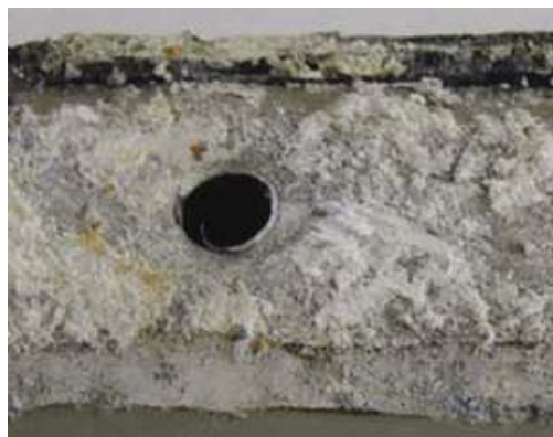
Рис. 1.4. Контактная коррозия листовой детали
