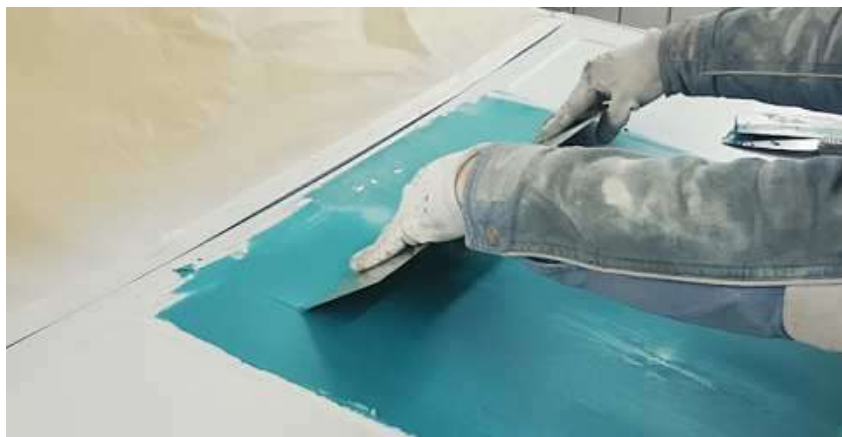
Рис. 2.2. Предварительное выравнивание
